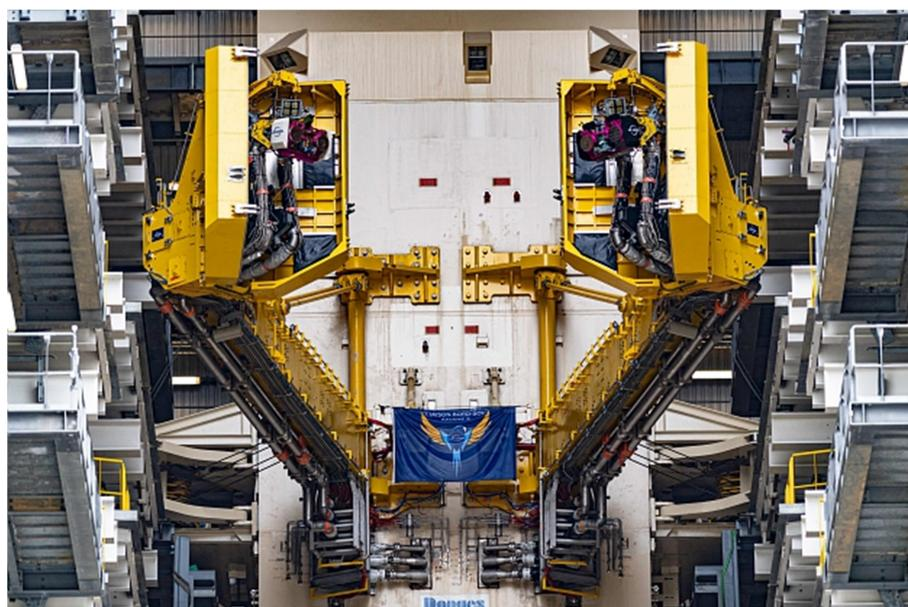
Tout à fait. Les bras cryos, ce qu'on appelle bras cryotechniques ou cryogéniques, ce sont les bras qui sont situés... Au niveau de la zone de lancement, vous avez une table métallique sur laquelle est posé le lanceur. À proximité, à 13 mètres du lanceur, vous avez un mât métallique qui monte à 66 mètres. À environ 38 mètres de hauteur, vous avez ces deux bras cryotechniques (ou cryogéniques) qui permettent à l'alimentation des réservoirs de l'étage supérieur en hydrogène et en
